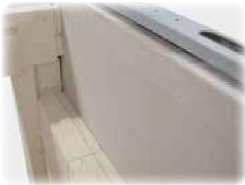
Meerlaagse isolatieopbouw van lichtgewicht isolatiestenen en een achterliggende isolatie die is afgestemd op de maximale temperatuur van de oven
